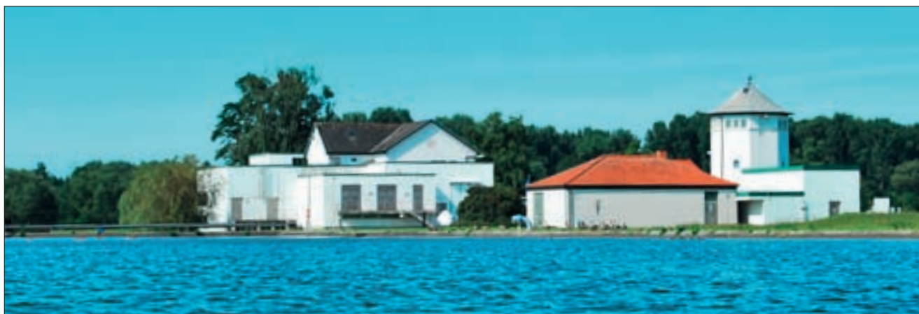
Das Wasserwerk Warmen liefert jeden Tag im Durchschnitt 38 000 Kubikmeter Trinkwasser nach Hamm.
