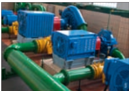
Die Pumpen befördern das Wasser in den Haarstrang-Speicher.
