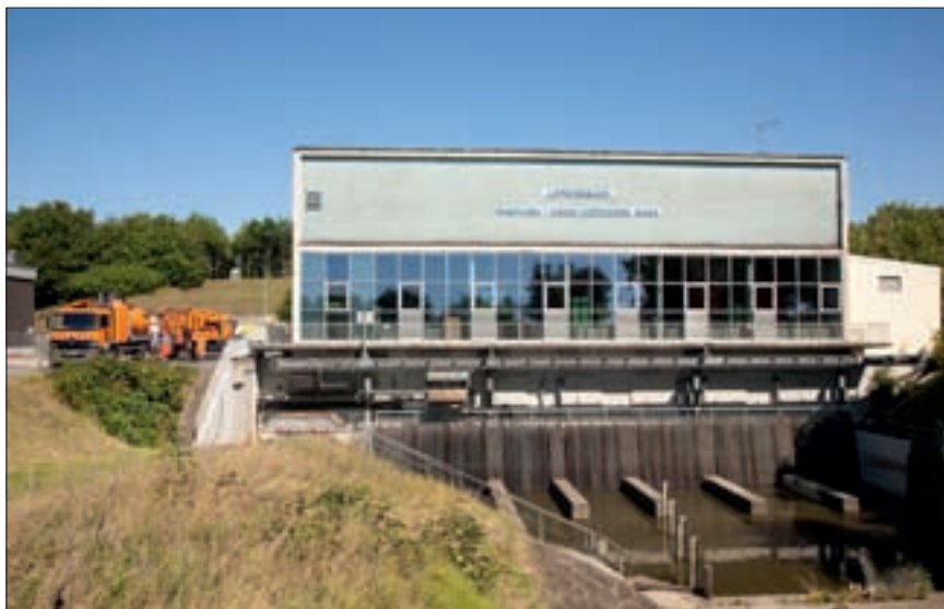
18 000 Liter pro Sekunde fördert das Pumpwerk Herringen Bach.
