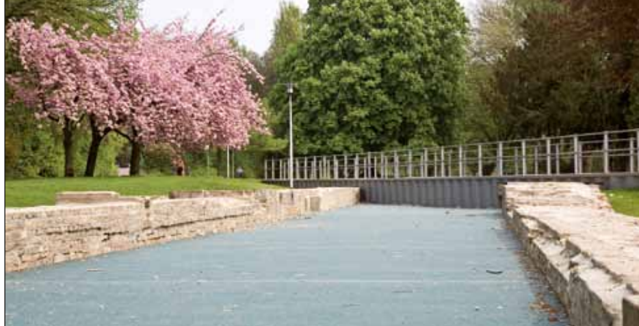
Restaurierte Schleuse im Nordring
