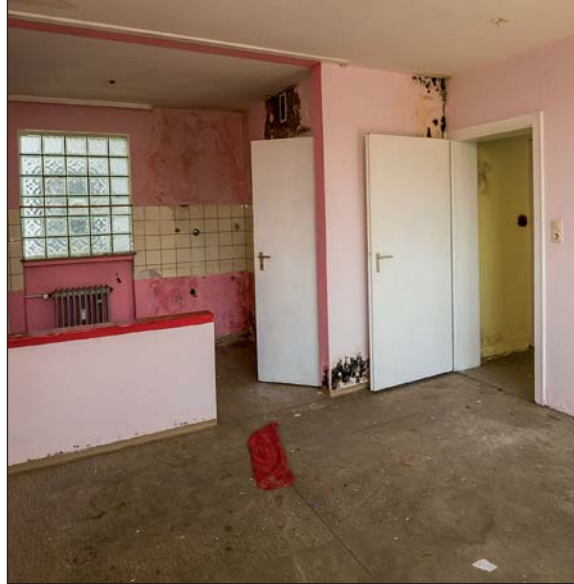
Innenansicht der Hochhäuser Münsterstraße vor dem Abriss
