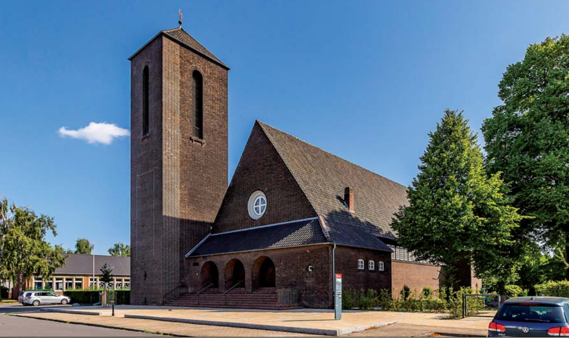
Die in den Jahren 1937/38 errichtete Johanneskirche mit neuem Vorplatz nach Enthüllung der „Geschichtsstele“.
