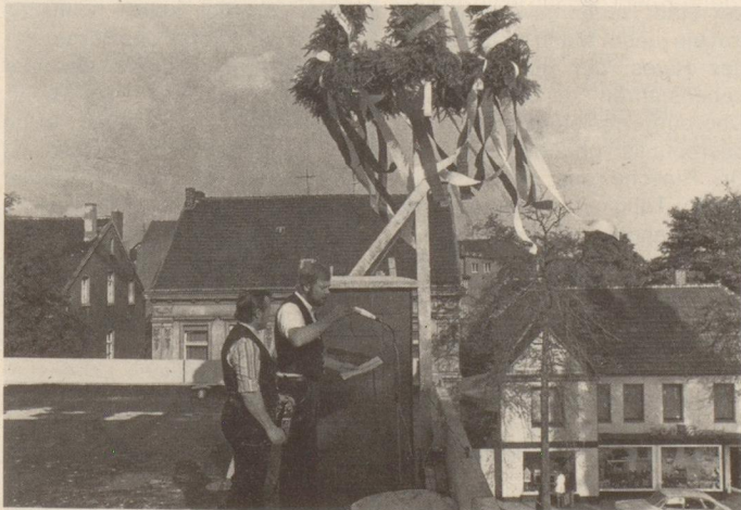
Der Richtkranz wehte Ende September über dem Neubau des Hammer Jugendzentrums. Im April 1975 soll das Haus bezugsfertig sein.
