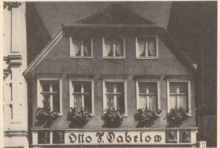
Die Giebelwand des Hauses Dabelow in der Hammer Weststraße.
