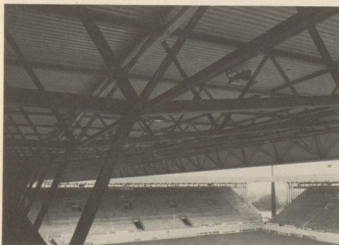
Aus Estel-Hohlprofilen: Die Tribünen-Konstruktion des Westfalenstadions in Dortmund.
