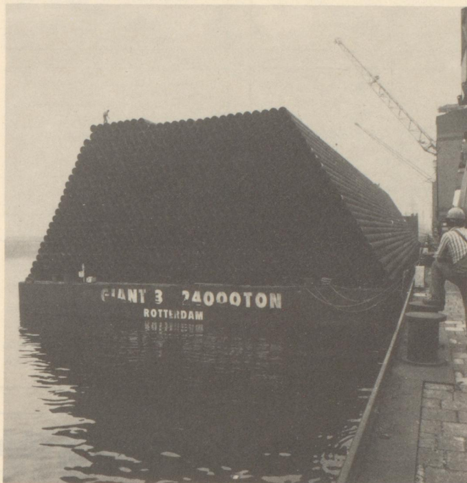
Der Super-Ponton „Giant 3“, der — von einem Schleppschiff gezogen — 15 000 Tonnen Großrohre aus dem Estel-Werk Barop über den Atlantik nach Argentinien transportiert.
