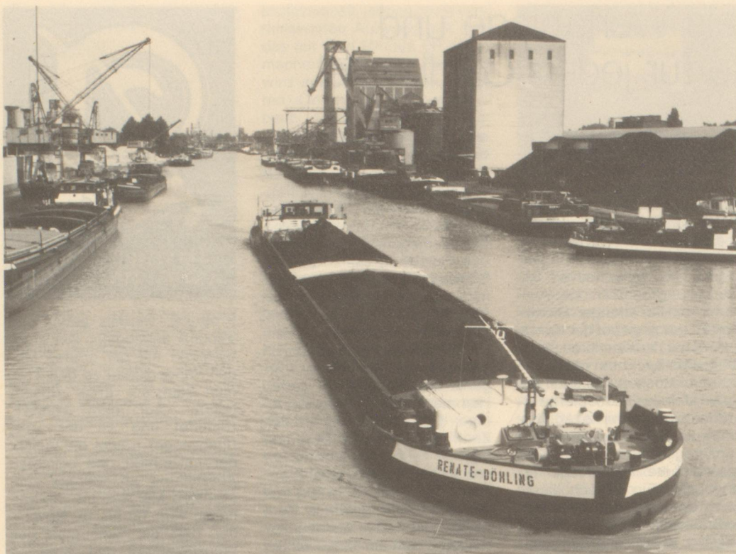
Blick von der Radbodbrücke in den Hafen.
