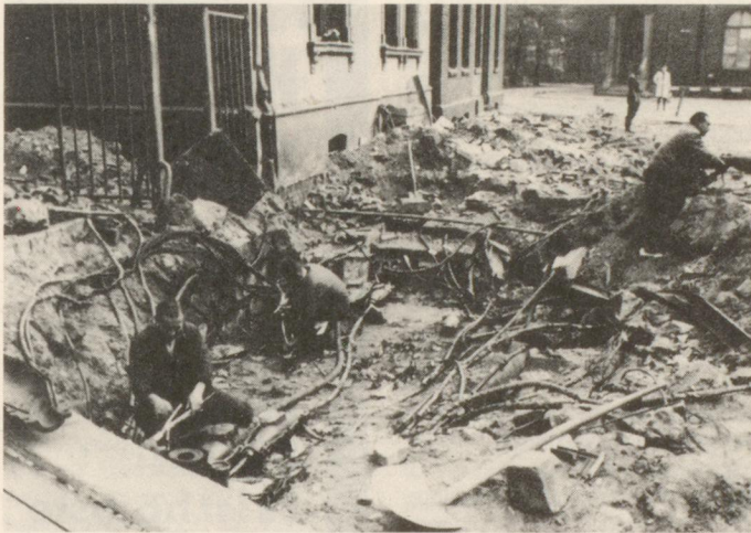
Auch die Hauptkabeltrasse hatte einen Volltreffer erhalten.
