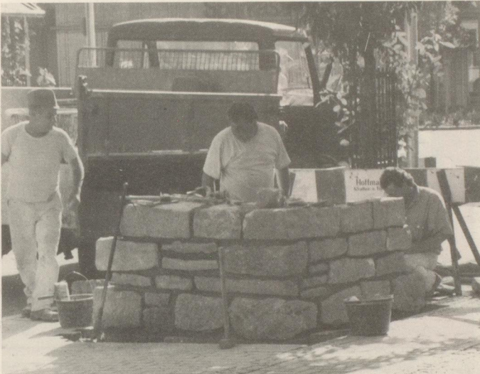
Als Teilkonstruktion des historischen Stadttores am Westentor wird dieser Mauerteil wieder erstellt, um die Lage sichtbar zu dokumentieren.
