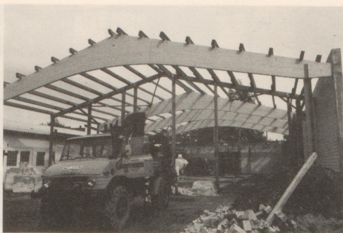
In Holzträgerbauweise entstand die neue Werkshalle der Firma Freericks.
