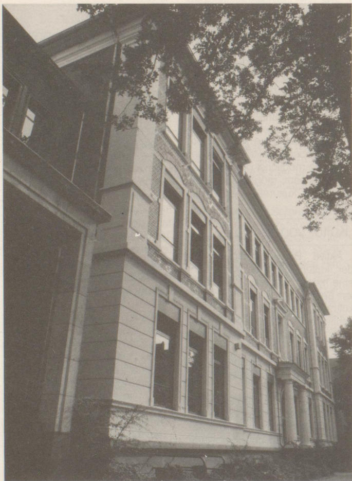
Zu einem Bildungs- und Begegnungszentrum umgestaltet werden soll das Gebäude der jetzigen Harkortschule.
