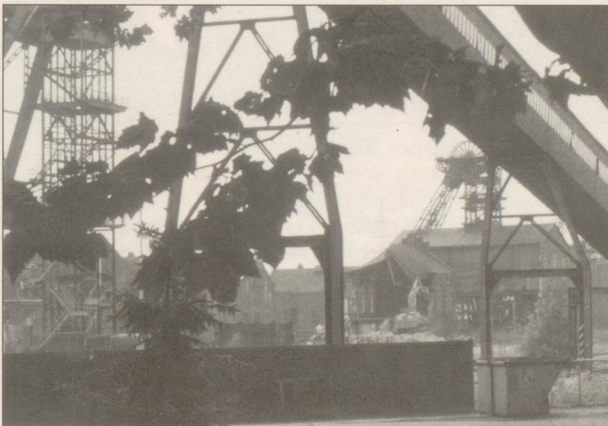
Beginnen haben die Abbrucharbeiten auf dem Gelände der ehemaligen Zeche Radbod Foto: L. Rettig
