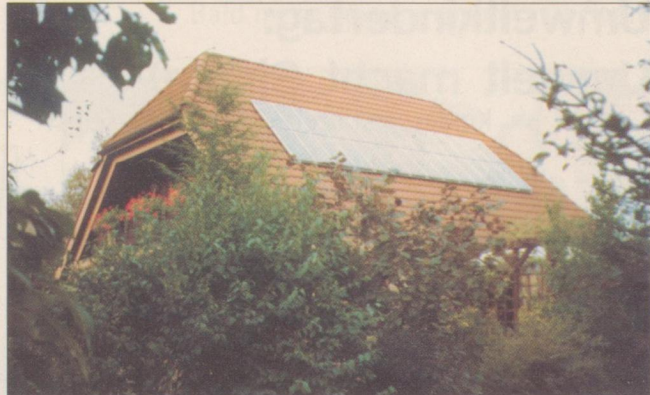
Mit Solarzellen einer Photovoltaikanlage - hier eine 2 KW-Anlage - kann man einen Teil des Stromverbrauchs selbst erzeugen.
