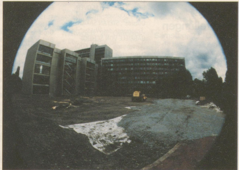
Begonnen haben die Bauarbeiten zur Erweiterung des Oberlandesgerichtes Hamm.
