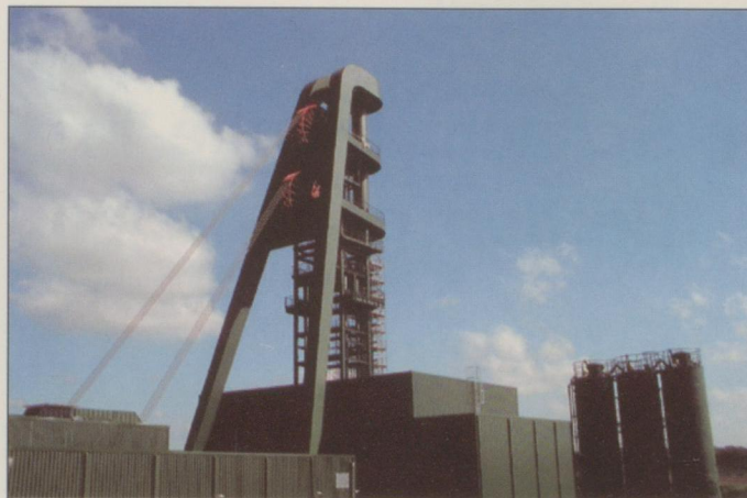
Im Schatten des 56 m Fördereturms befindet sich die Zentralkälteanlage.
