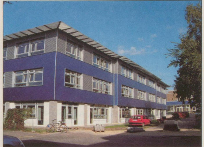
Zum Schuljahresbeginn wurde der Erweiterungsbau am Märkischen Gymnasium seiner Bestimmung übergeben. Foto: L. Rettig
