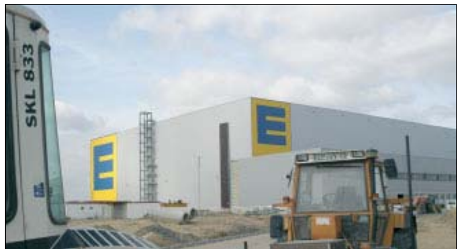
Hoch im Bau: Das Edeka-Logistikzentrum an der A2 bei Rhyern.
