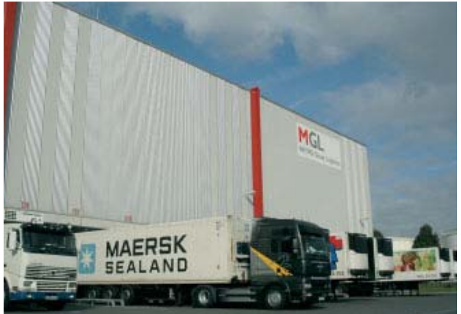
Wichtige Schaltzentrale: Das Metro-Logistikzentrum im Westhafen.
