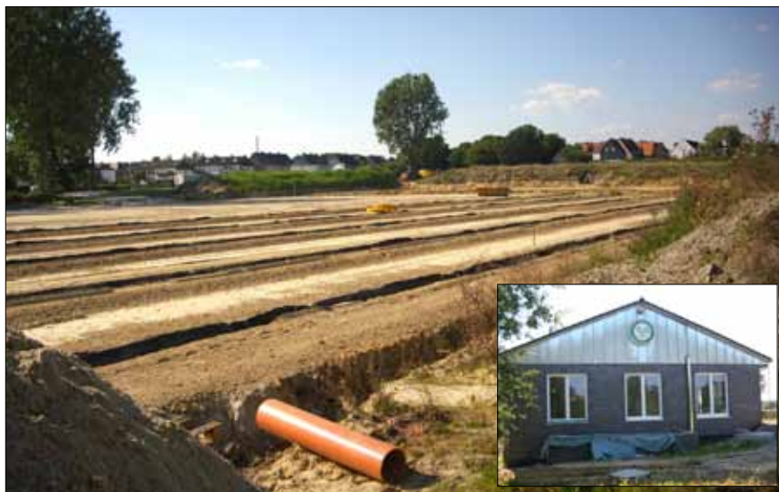
Das Vereinsheim ist fast fertig, die Einweihung des Kunststoffrasenplatzes verzögert sich wegen Bodenproblemen bis zum Frühjahr.
