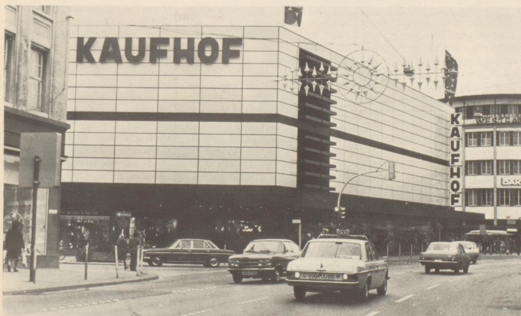
Nach umfangreichen Umbauarbeiten präsentiert sich der Kaufhof mit einer neuen Fassade.
