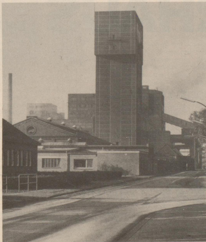
Auch im Ausbauschwerpunkt des Bergwerkes Heinrich-Robert in Hamm-Herringen wurden zur Ortung von Gebirgsschlägen elektrodynamische Erschütterungsmesser installiert.
