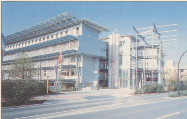
Das Technische Zentrum der Sparkasse an der Münsterstraße.
