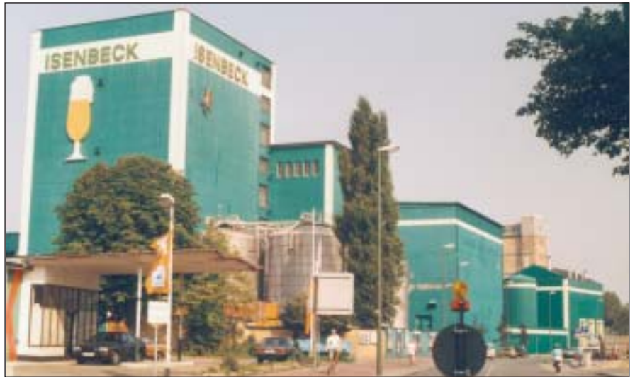
Der Komplex der ehemaligen Isenbeck-Brauerei am Westenwall.
