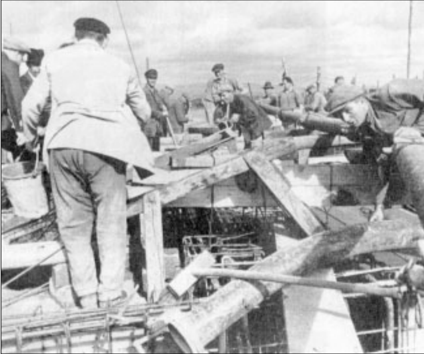
Im Jahr 1935: Arbeiter beim Brückenbau an der A2.
