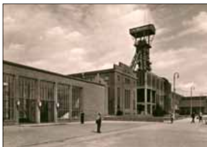
Der Schacht Franz wurde 1927 in Betrieb genommen.
