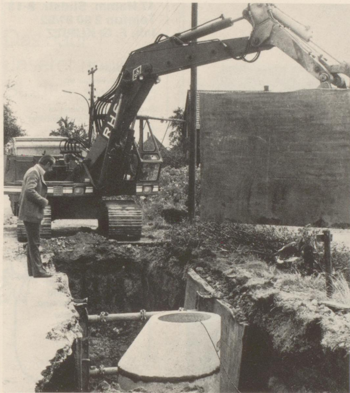
Mehrere große Kanalbauprojekte wurden im vergangenen Jahr in den verschiedenen Bereichen der Stadt in Angriff genommen. Unser Bild zeigt die Arbeiten auf der Fischerstraße im Stadtteil Berge.
