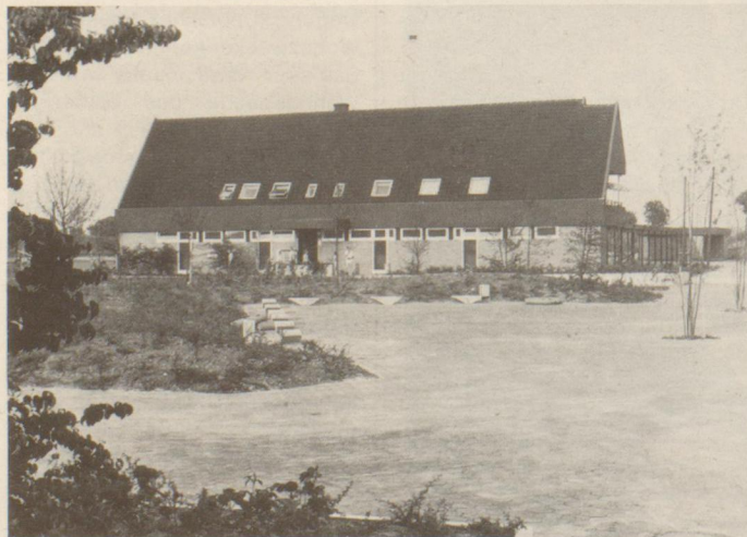
Der Selbachpark, der im Frühsommer eröffnet werden konnte, wurde von der gesamten Bevölkerung als Erholungszentrum begrüßt.
