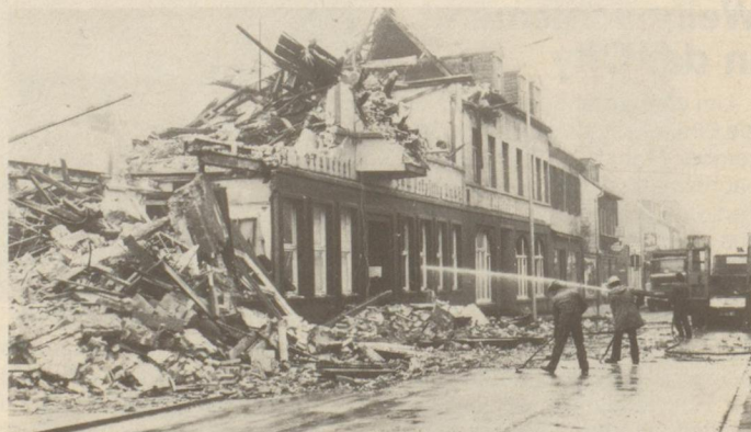
Abbruch: Für einen neuen städtebaulichen Akzent wird Platz geschaffen.
