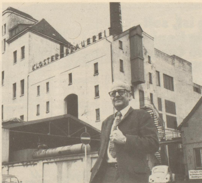
Heute Streitobjekt — früher Standort der renommierten Klosterbrauerei: Unser Bild zeigt den Gebäudekomplex vor dem Abriß, davor Braumeister Voith, der letzte seines Zeichens in der Klosterbrauerei.
