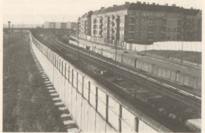
Blick auf die Sperranlagen zwischen Wedding und Pankow.
