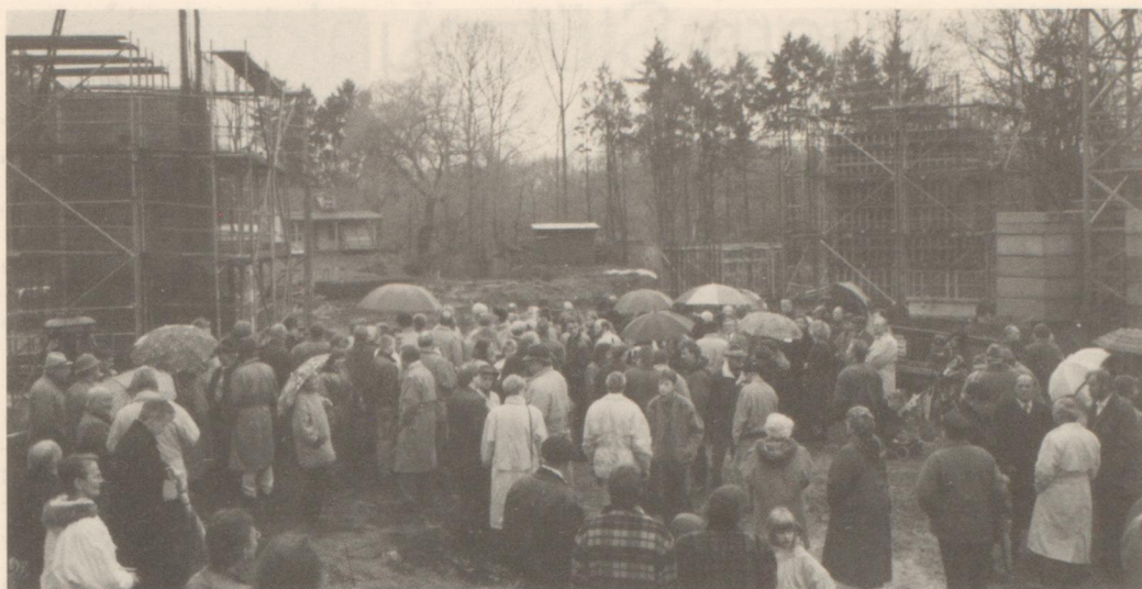
Unter reger Anteilnahme der Bevölkerung wurde am 22. November der Grundstein für den Tribünenneubau der Waldbühne Heessen gelegt.
