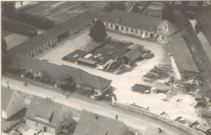
Auf dem Luftfoto von 1956 liegt der ehemalige Bauhof der RAG noch in ländlicher Umgebung. Inzwischen ist der Umbau zur Begegnungsstätte in vollem Gange.
