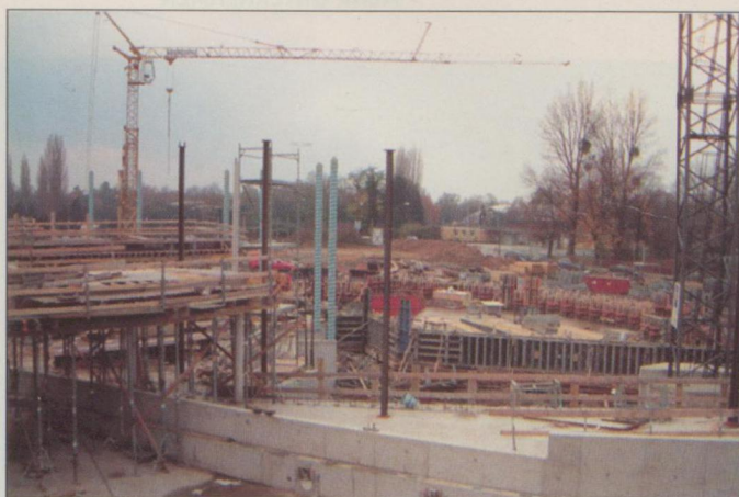
Wo heute noch Baustelle ist, wird in einem Jahr die Erlebnistherme mit ihrem Reha-Bereich Besucher anlocken.
