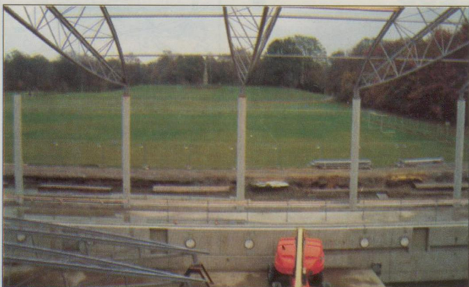
Auf den „Exer“ geht der Blick von der Tribüne.
