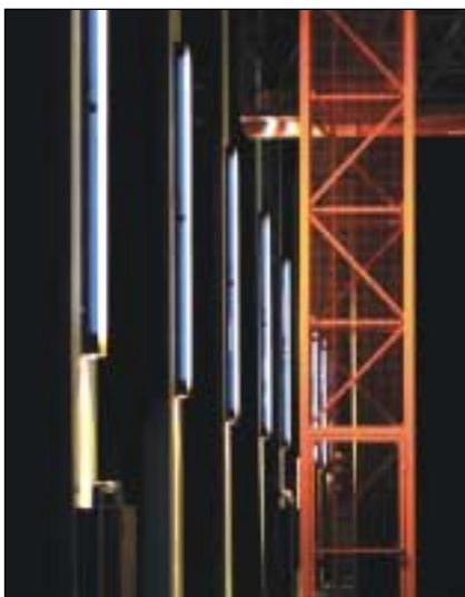
Effektvolle Beleuchtung: Speziell für die Alfred-Fischer-Halle entwickelt.
