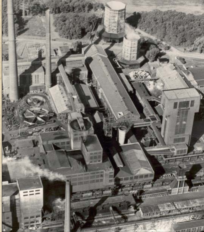
Zur Errichtung der Zeche Heinrich-Robert kaufte die Bergwerksgesellschaft De Wendel in Pelkum und Herringen riesige Flächen auf.
